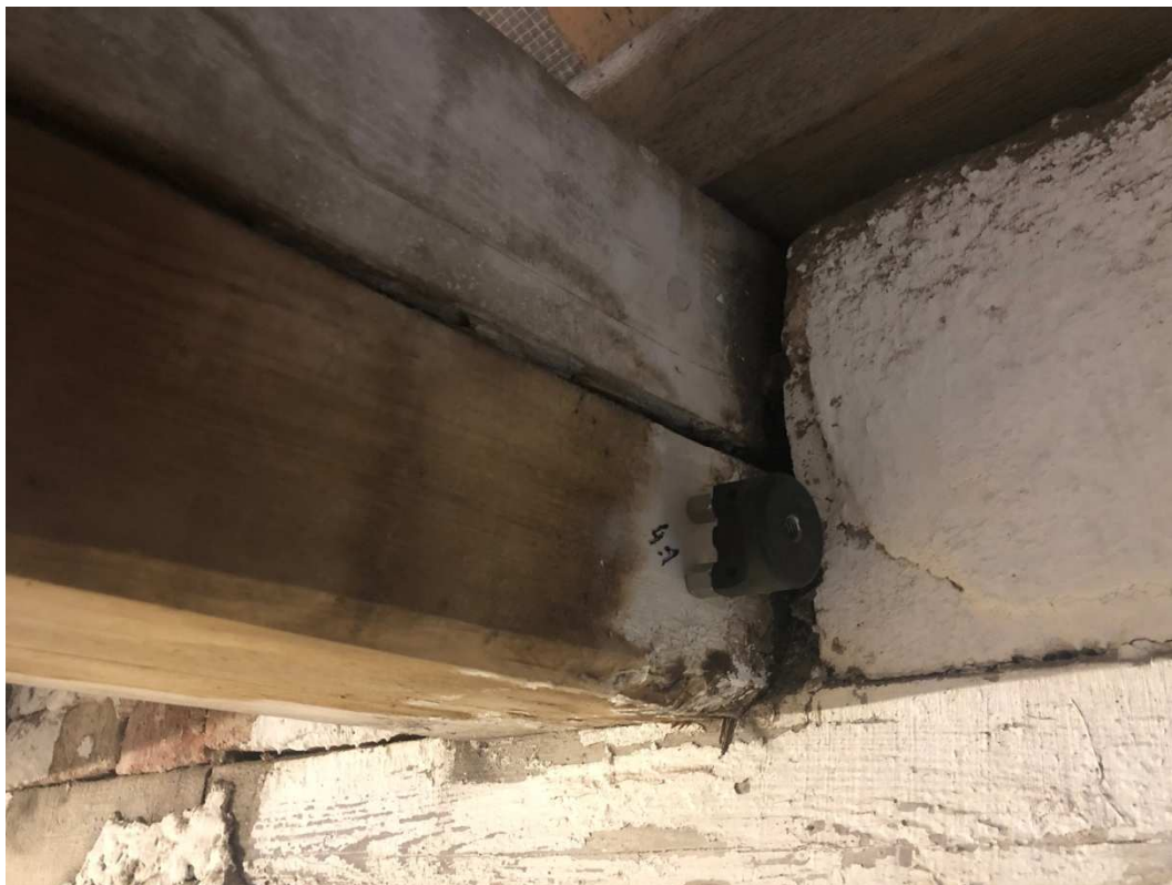
Foto č. 11 Měření vlhkosti bodu 4.1 (27.3.2021)
