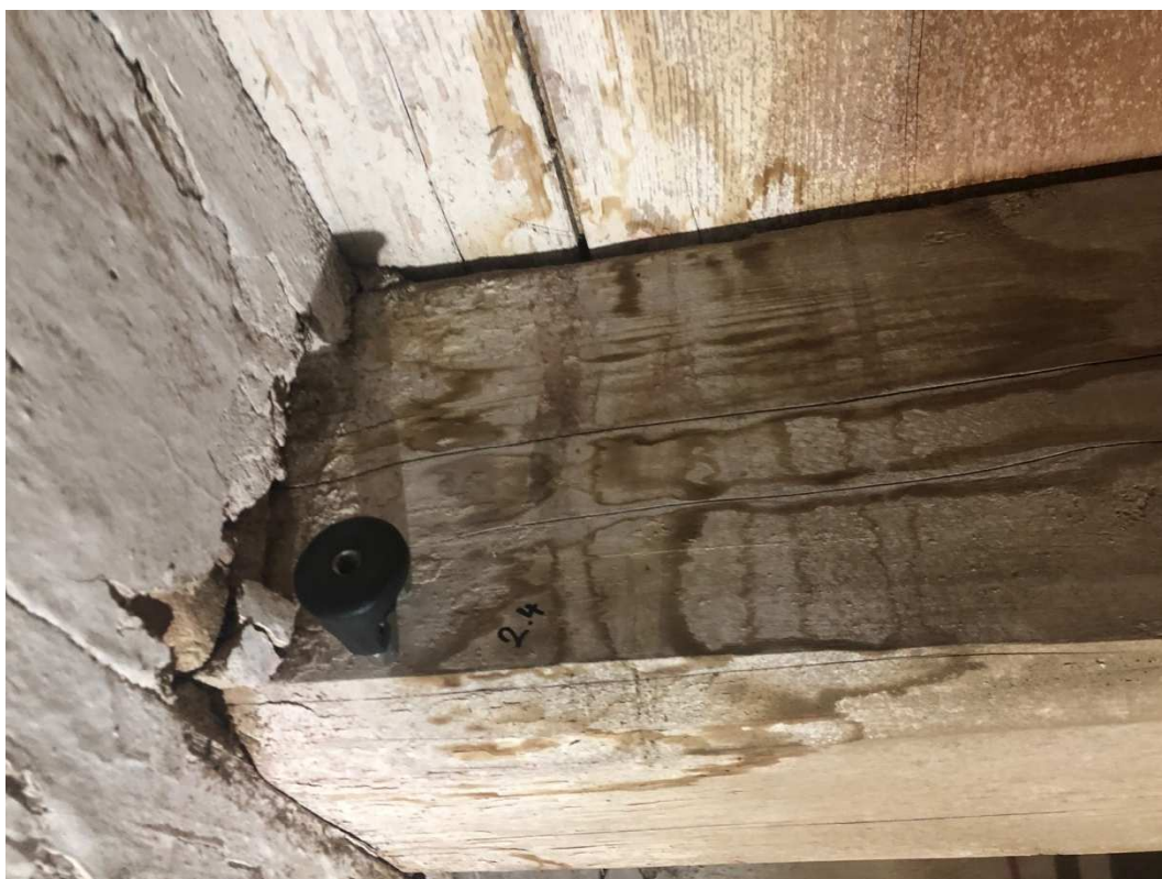
Foto č. 9 Měření vlhkosti bodu 2.4 (27.3.2021)
