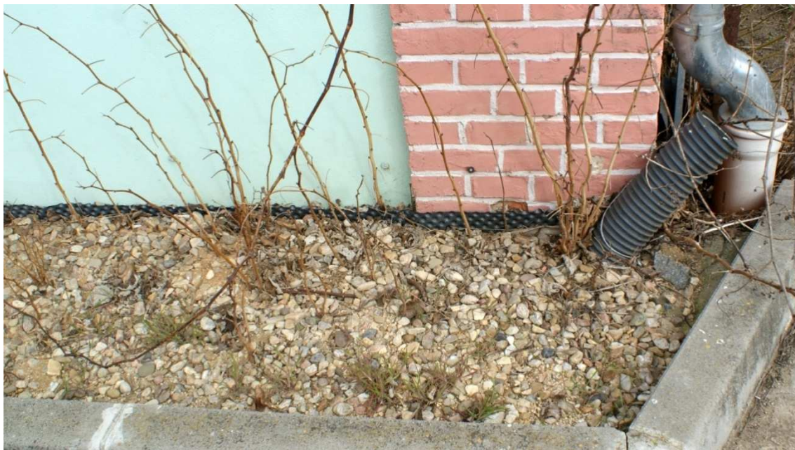
Foto č. 38 Ukončení nopové folie na rohu západní a jižní fasády.
