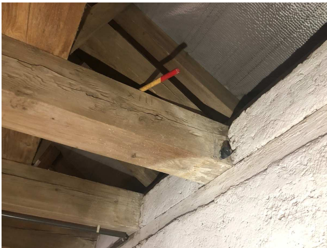
Foto č. 14 Měření vlhkosti bodu 4.4 (27.3.2021)
