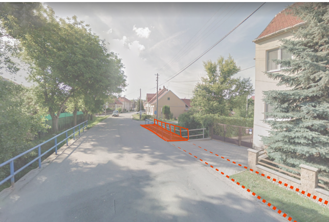
04 Současná situace mostu v Bedřichovicích neumožňuje bezpečný a pohodlný průstup pro pěší. Návrh rozšiřuje mostovku tak, aby bylo možné vybudovat chodník. Variantou je zúžení silnice.
