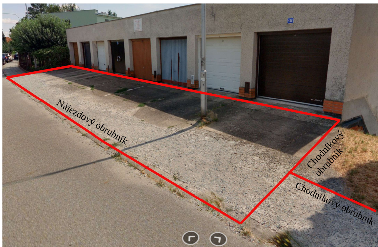
Vjezd před garážemi
