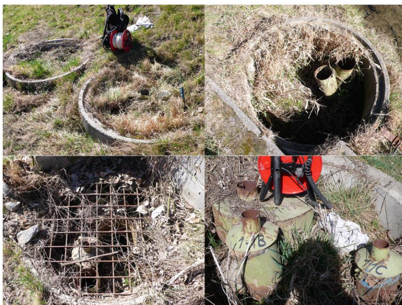
Obr. 9 Nevhodný stav subhorizontálního drénu v roce 2012 (Ulman a kol. 2012)
